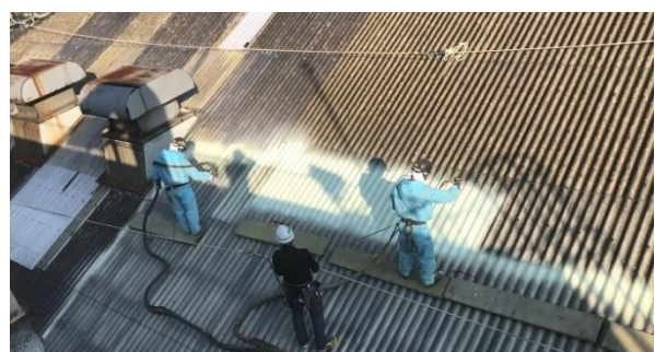
【SOSEI 施工風景】
