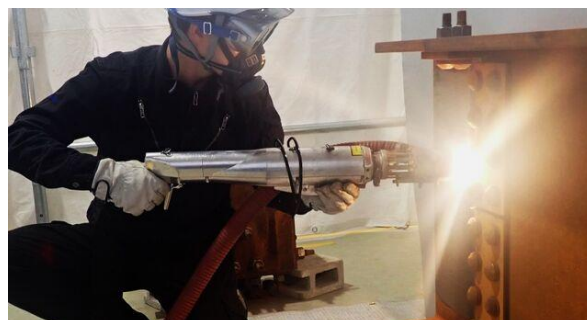
【CoolLaser 施工風景】
